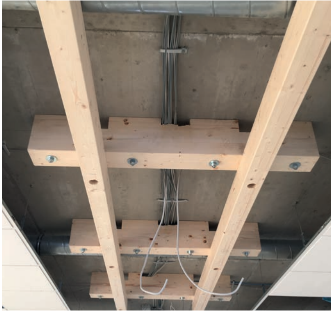
Abb.: Unterkonstruktion für zwei nebeneinander liegende T-Schienen
