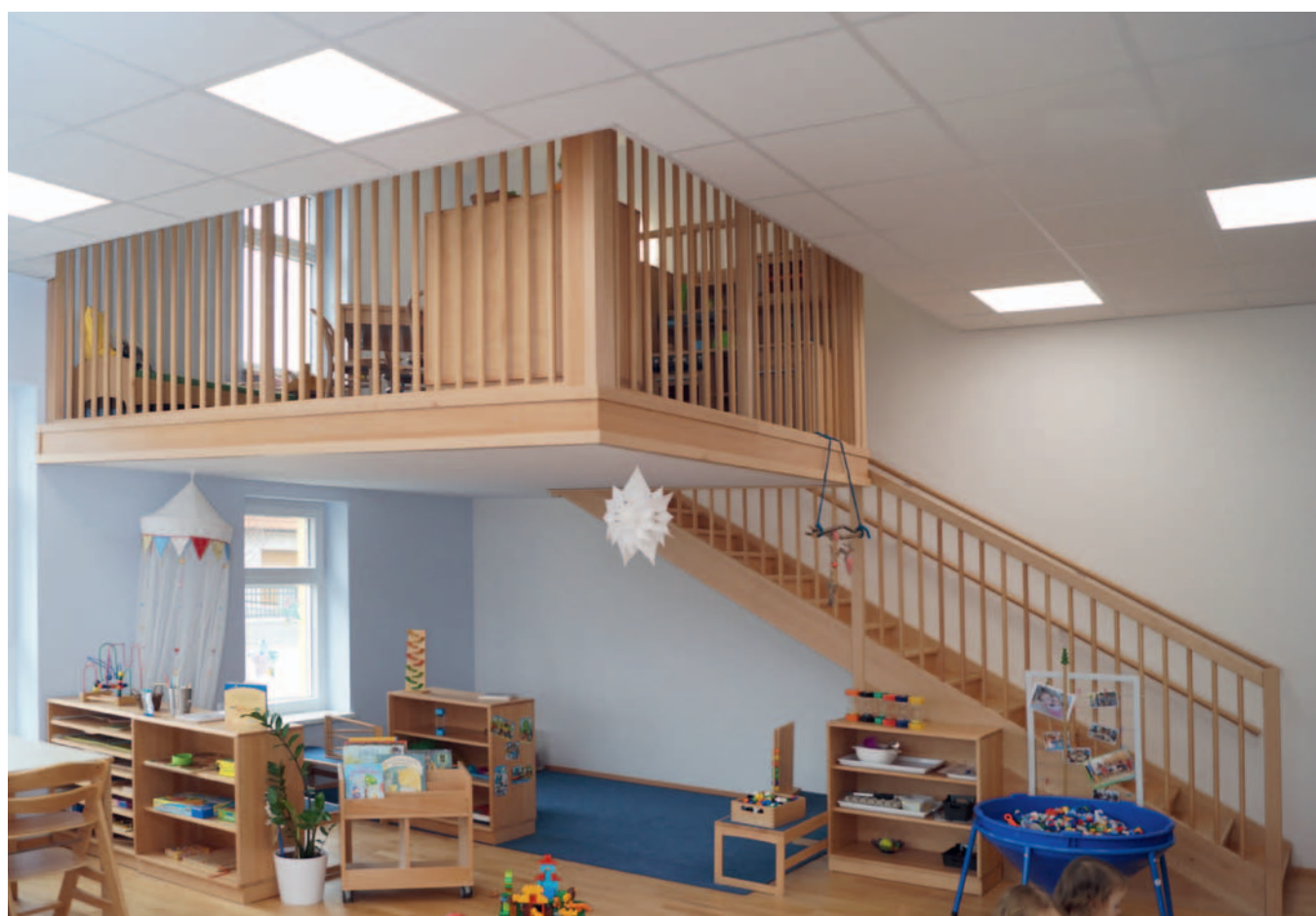
Stiegenaufgang mit Galerie-Geländer (Podestebene bauseits)
